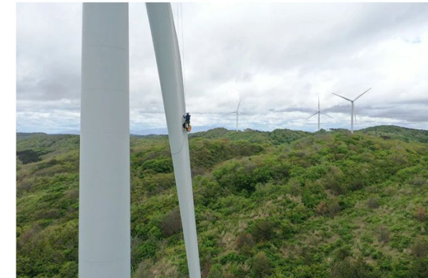
風力発電所のブレードを点検をする作業員=2021年5月11日午前、秋田県由利本荘市、ドローンで小平重隆撮影
