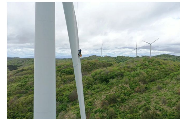
風力発電所のブレードを点検をする作業員=2021年5月11日午前、秋田県由利本荘市、ドローンで小平重隆撮影
